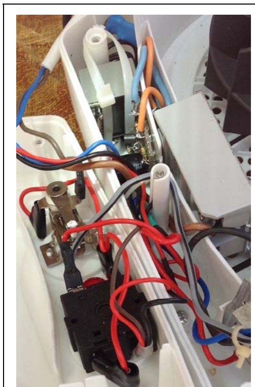
Bild 3: Einbau der Steuerschaltung
